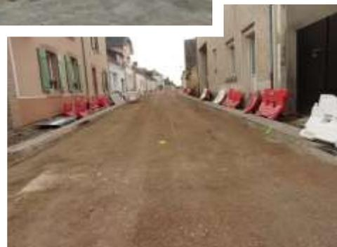
Sur les trottoirs, application d'un béton, bouchardé après quelques semaines de séchage.
