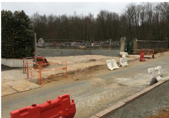
Au fil des jours et de l'avancement des travaux, une partie du mur d'enceinte du cimetière est démolie ; créant un nouvel espace de stationnement plus sécuritaire et accessible aux Personnes à Mobilité Réduite (PMR). Un nouveau muret est construit, surmonté d'un garde-corps en ferronnerie. A l'automne, une haie arbustive sera plantée et un nouvel abri installé derrière le mur, côté cimetière, pour isoler ce lieu de recueillement. Deux candélabres ont été implantés pour éclairer ce secteur.
